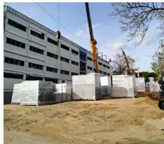
Arribada dels climatitzadors a l'obra. El sistema de climatització de l'hospital és força sofisticat.
